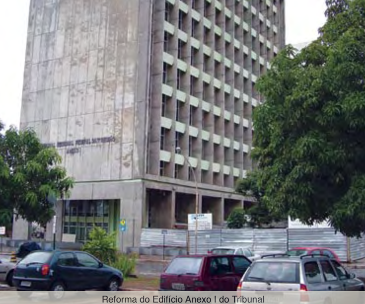
Reforma do Edifício Anexo I do Tribunal
