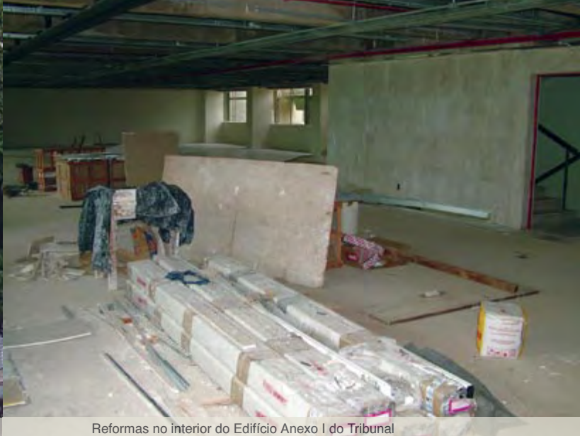
Reformas no interior do Edifício Anexo I do Tribunal
